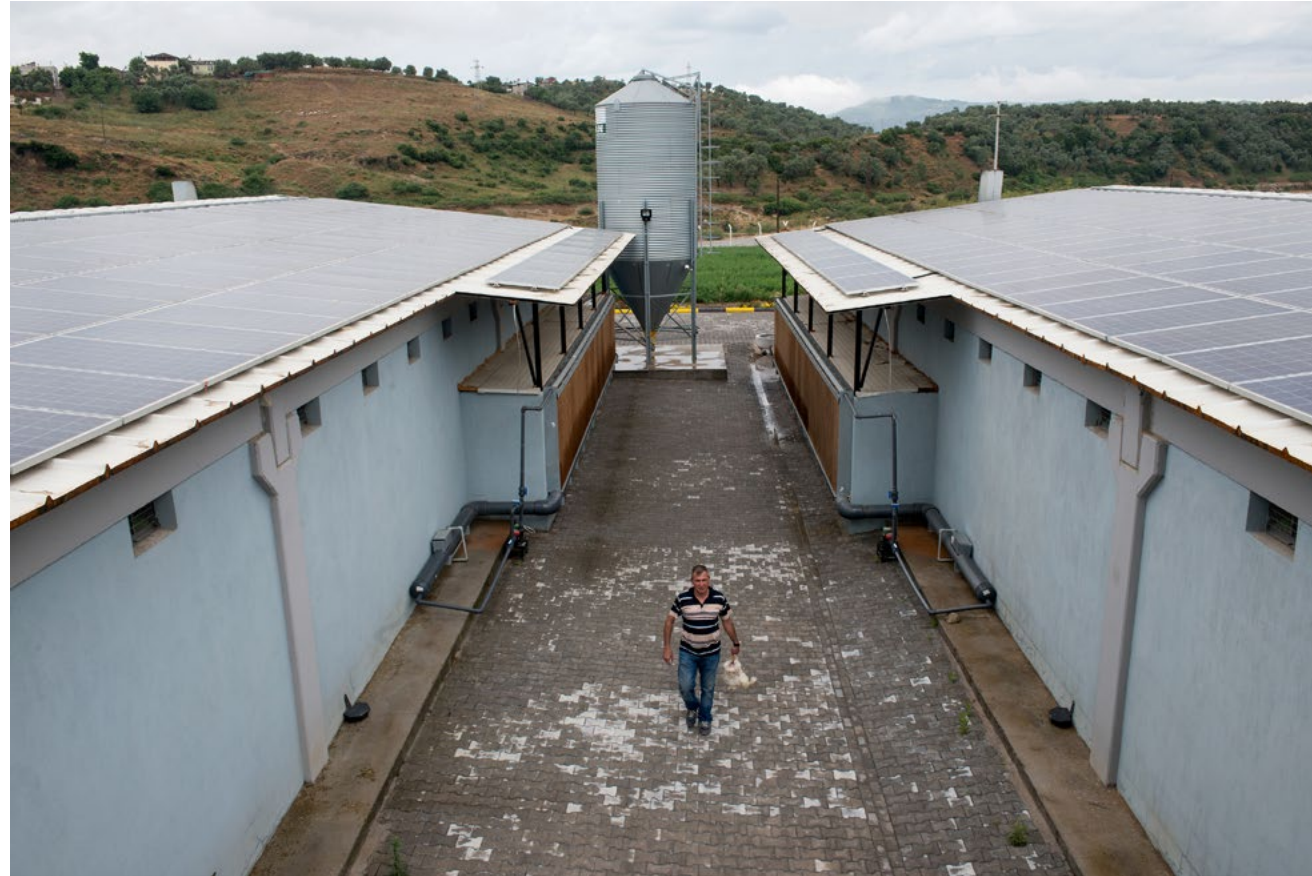
A poultry farm in Aydin, installed 2,000 solar panels on the roof of the poultry house, reaching a capacity of 500 KW. © Mathias Depardon pour l'Agence Française de Développement.
